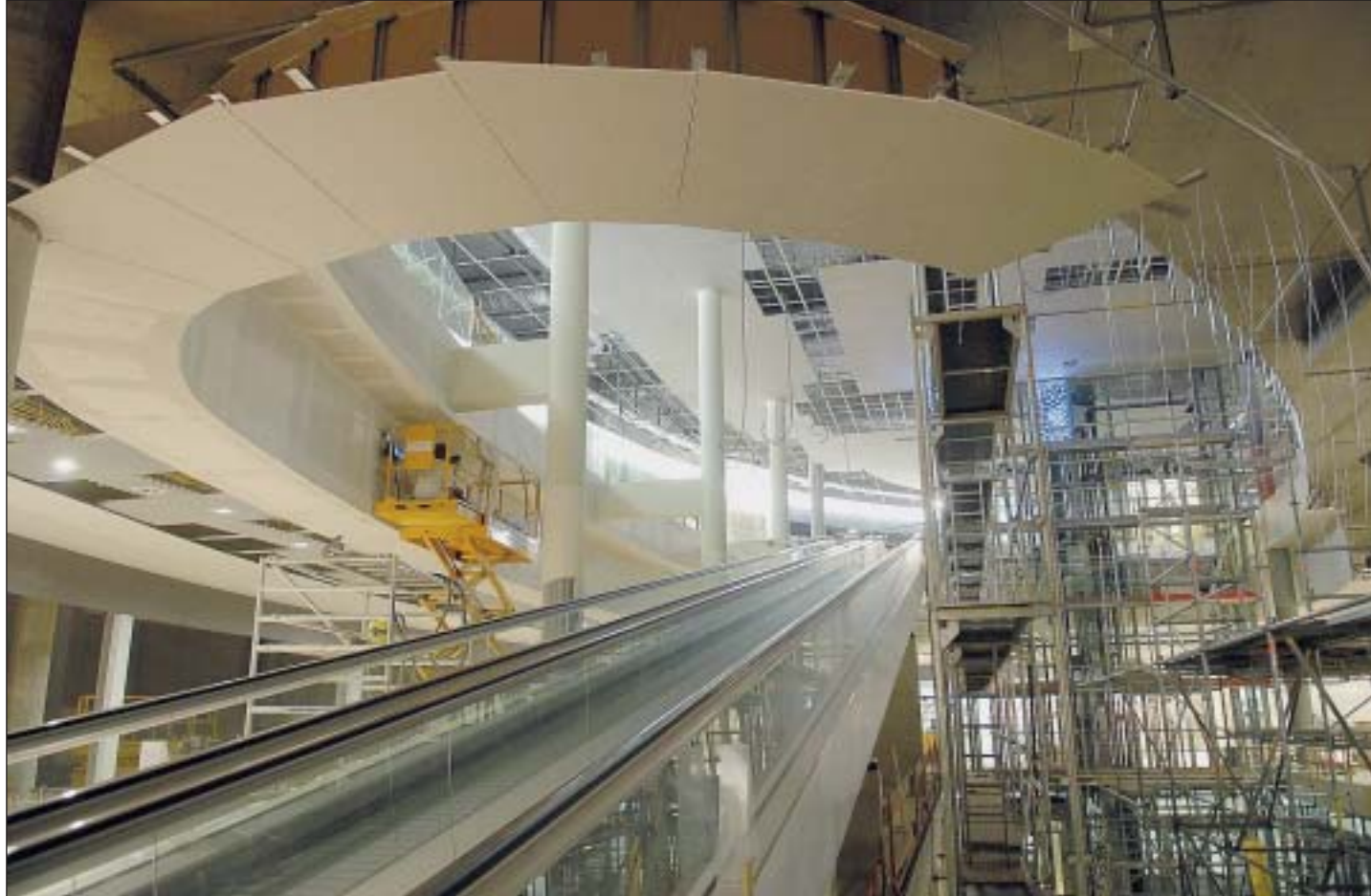
Au cœur du centre commercial, une fosse de 32 mètres de long pour 18 mètres de large, sur trois étages.
