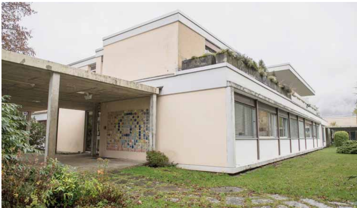
La fondation Borel, à Dombresson, possède plusieurs bâtiments dans lesquels sont répartis les différents partenaires. LUCAS VUITEL
