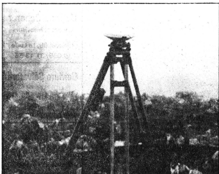
Un satellite à La Vue-des-Alpes pour éviter, lors du percement du futur tunnel, des risques d'erreur d'alignement. (AP)
