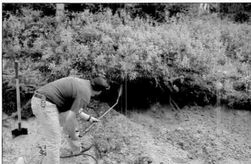
Excavation des racines avec un jet d'eau à pression.
