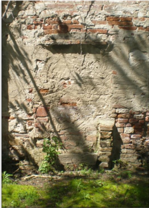
Fig. 17 Dettaglio dell'apertura tamponata
