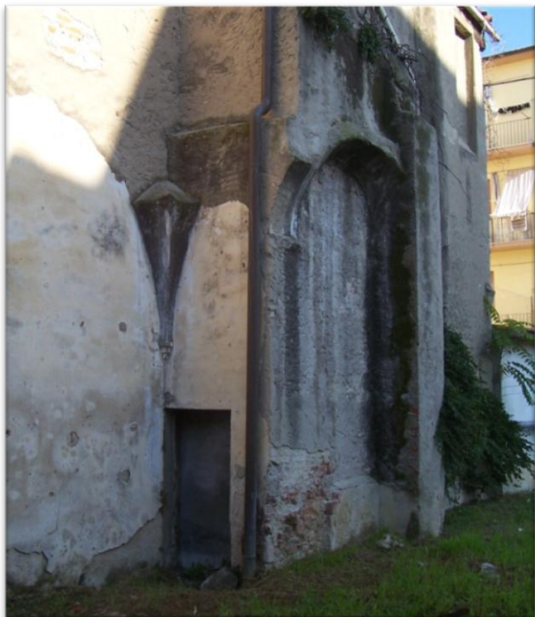
Fig. 15 Dettaglio degli elementi di imposta di volte sulla parete sud
