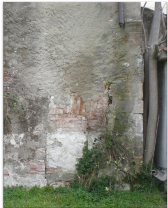
Fig. 18 Dettaglio dell'apertura tamponata e dei blocchi angolari in pietra
