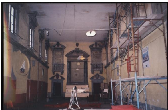
Fig. 10 Il controsoffitto fatto inserire dalla Soprintendenza
