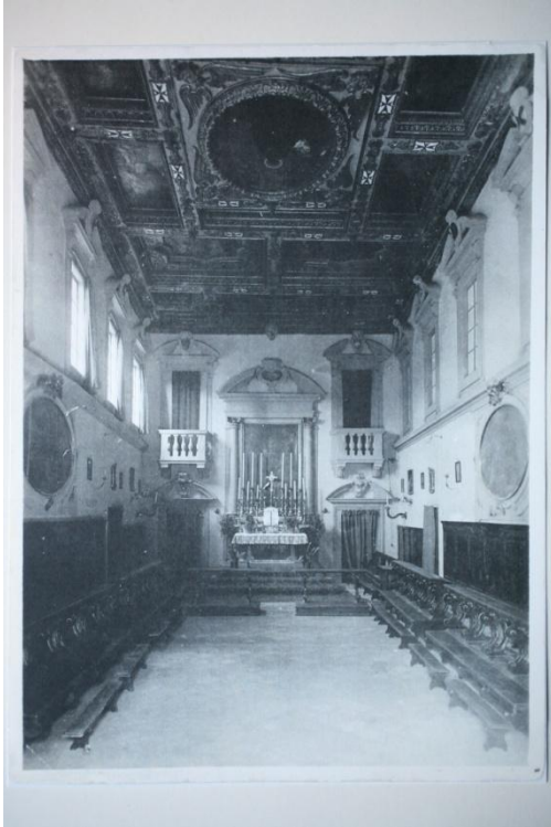
Fig. 7 L'interno della chiesa nel 1941
