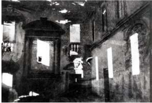
Fig. 8 L'interno della chiesa dopo il bombardamento
