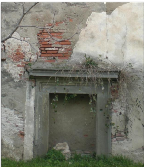
Fig. 16 Dettaglio dell'accesso laterale tamponato con cornice in pietra serena
