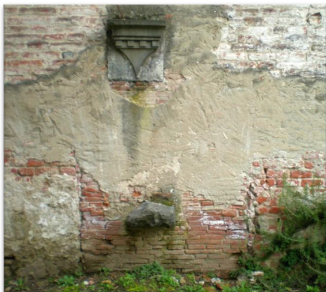
Fig. 14 Dettaglio della parete sud, ben visibile il peduccio
