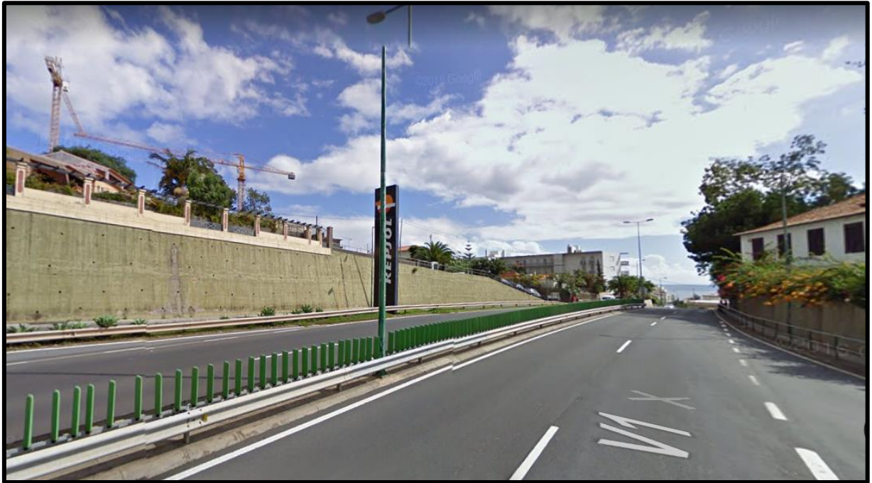
Figura 57 – Vista da ER 115, VR1-Rotunda D. Francisco Santana
