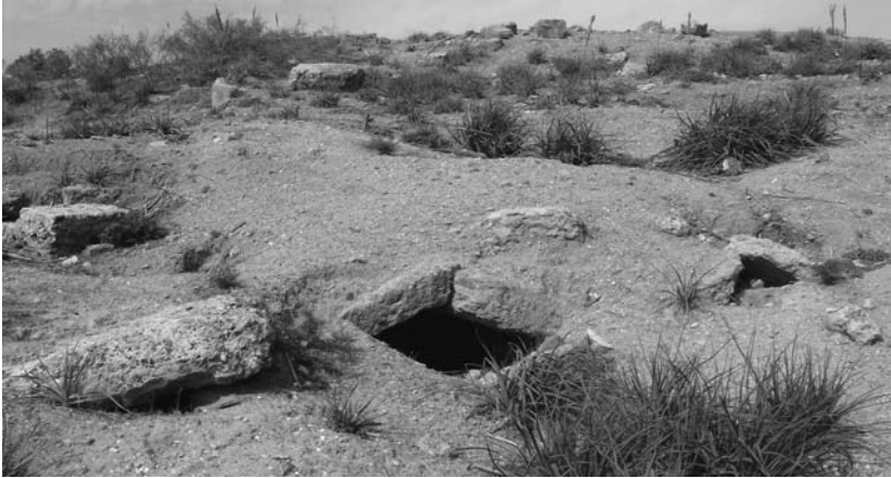
Fig. 13: Kalaat Bezzaz, vestiges de citernes puniques accolées creusées dans le palier inférieur du secteur sud de l'enceinte de la forteresse: couvertures en dalles disposées en bâtière (cliché H. Baklouti).
