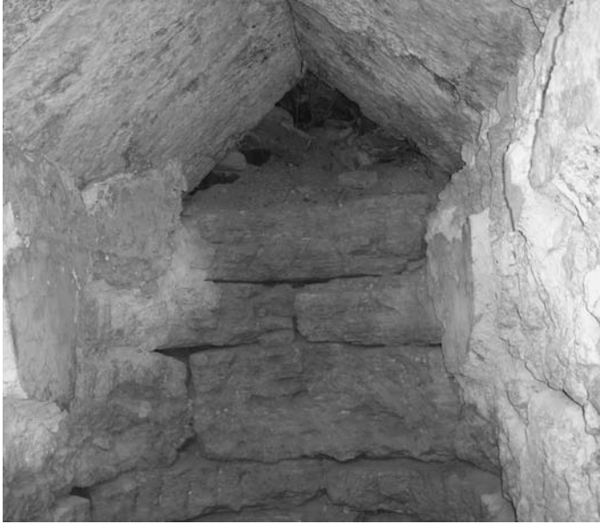
Fig. 20: Kalaat Bezzaz, citerne punique vue de l'intérieur, dalles de couverture, maçonnerie et enduit d'étanchéité (cliché H. Baklouti).
