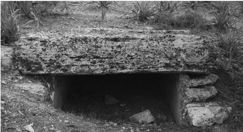
Fig. 14: Kalaat Bezzaz, vestiges d'une citerne punique à l'angle nord-ouest du secteur nord de l'enceinte de la forteresse: couverture en dalles posées à plat (cliché H. Baklouti).
