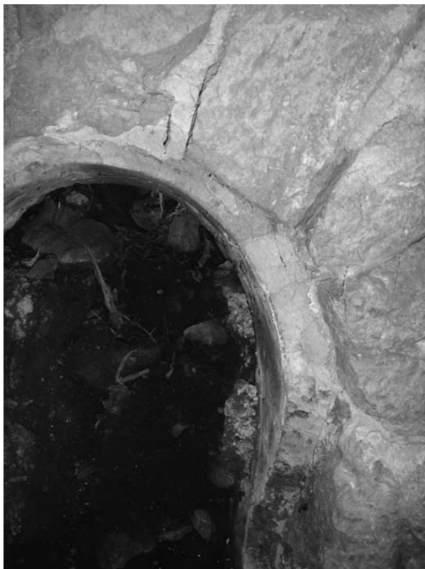
Fig. 22: Kalaat Bezzaz, citernes puniques à l'angle nord-est: enduit d'étanchéité gris cendré revêtant les parois d'une porte de communication (cliché H. Baklouti).
