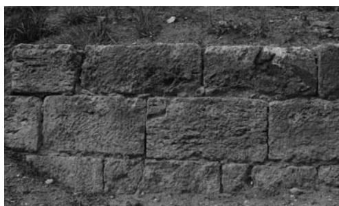
Fig. 11: Kalaat Bezzaz, vestiges du mur d'enceinte sud de la forteresse, détail de la maçonnerie de la courtine (cliché H. Baklouti).
