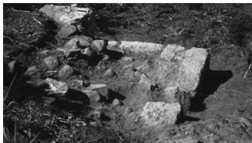
Fig. 12: Substruction de l'enceinte à l'angle nord-est de la forteresse (cliché H. Baklouti).
