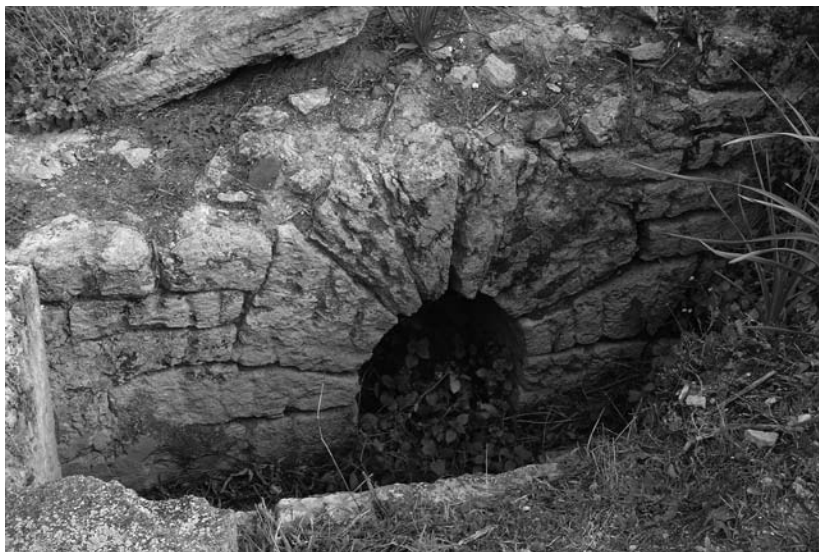
Fig. 21: Kalaat Bezzaz, citernes puniques à l'angle nord-est: porte de communication arquée, clavée et voûtée (cliché H. Baklouti).
