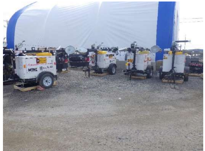
Photo 2.1 Bac de rétention sous les tours de lumières
