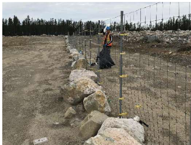
Photo 2.5 Photo du nettoyage du LEET (septembre 2018)
