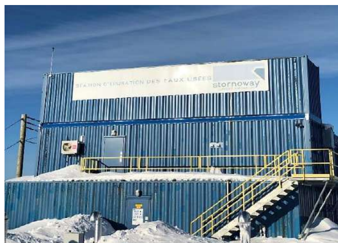
Photo 3.33 Usine de traitement des eaux usées domestiques
