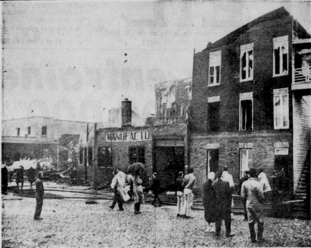
BADAUDS ET POMPIERS examinent les restes calcinés des établissements détruits par le feu.
