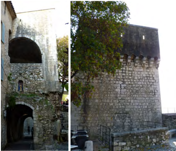
Tour porte ouverte à la gorge - mâchicoulis et archère cruciforme vers l'extérieur (Cl. E.G.)
