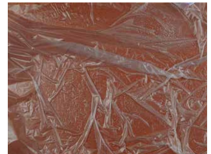
Effet marbré : Film sur la surface talochée
