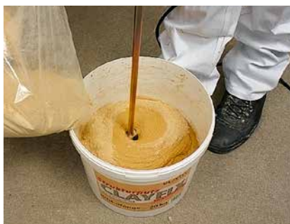
Mélanger le contenu du seau dans de l'eau. Ensuite, laisser reposer pendant 30 minutes.
