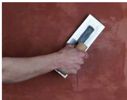
Mise en œuvre d'un talochage irrégulier
