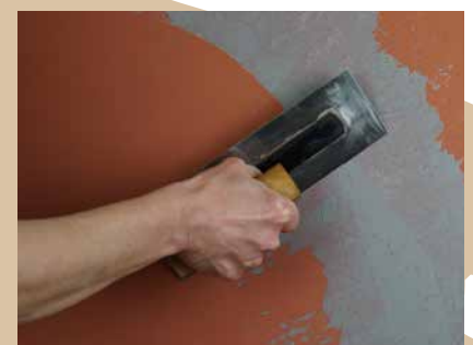
Appl. de la couche de finition marbrée.
