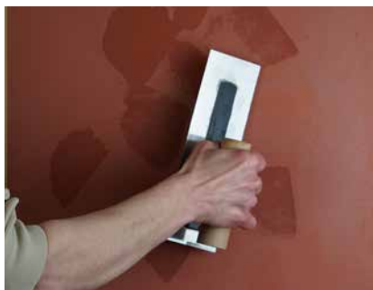
Application d'un talochage irrégulier
