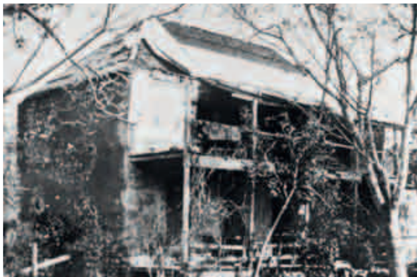
Maison détruite par un cyclone à Canala, fonds David, coll. SANC
