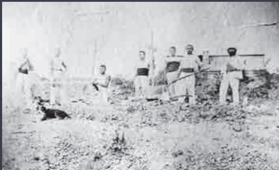
Soldats au travail , album du sergent Pinçon, fonds Kakou, coll. SANC Tout comme les soldats des postes de l'intérieur de la colonie, les soldats en poste à Nouméa ont assuré la construction de tout l'arsenal défensif de la ville avec l'aide d'un certain nombre de transportés.
