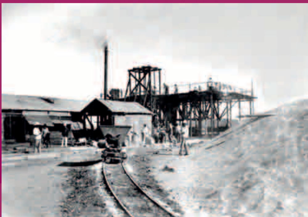
Voie Decauville, partant de la Vallée-du-Tir et aboutissant au port , album Guiart, coll. SANC Dans son édition du 26 octobre 1899, La Calédonie décrit ainsi le début des travaux des quais : « Le service des travaux municipaux a ouvert un nouveau chantier sur le flanc nord de la butte qui se trouve sur l'alignement de la rue Rivoli [...], une voie Decauville partant de la vallée du Tir et contournant toute la partie nord du bâtiment de l'hôpital vient aboutir au débarcadère de la capitainerie du port. Là viennent aussi d'être commencés les premiers travaux nécessaires pour permettre de continuer la plate-forme du chemin de fer Decauville. » L'objectif est d'établir un lien entre le port et la voie de chemin de fer.
