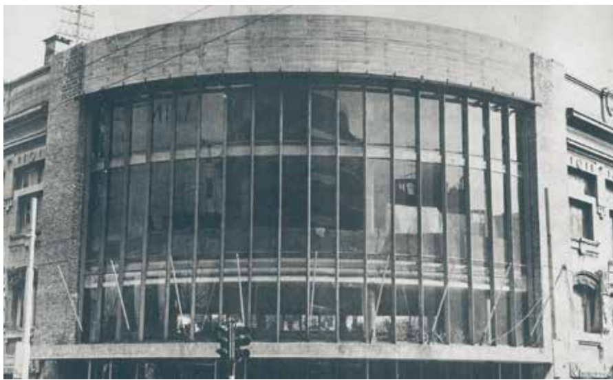
Estudio Auditorio del Sodre. Así lucía su fachada en 1971, año del incendio
