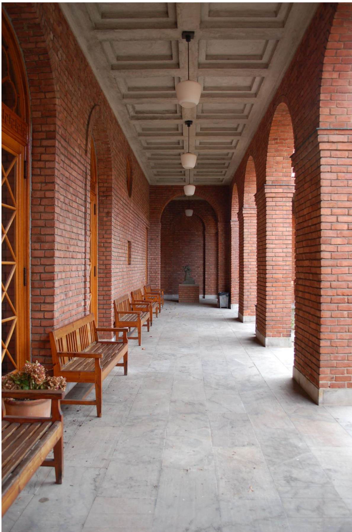
Loggia på baksiden av midtbygningen – med adkomstdører fra vestibyle og kassettert himling i jernbetong.
