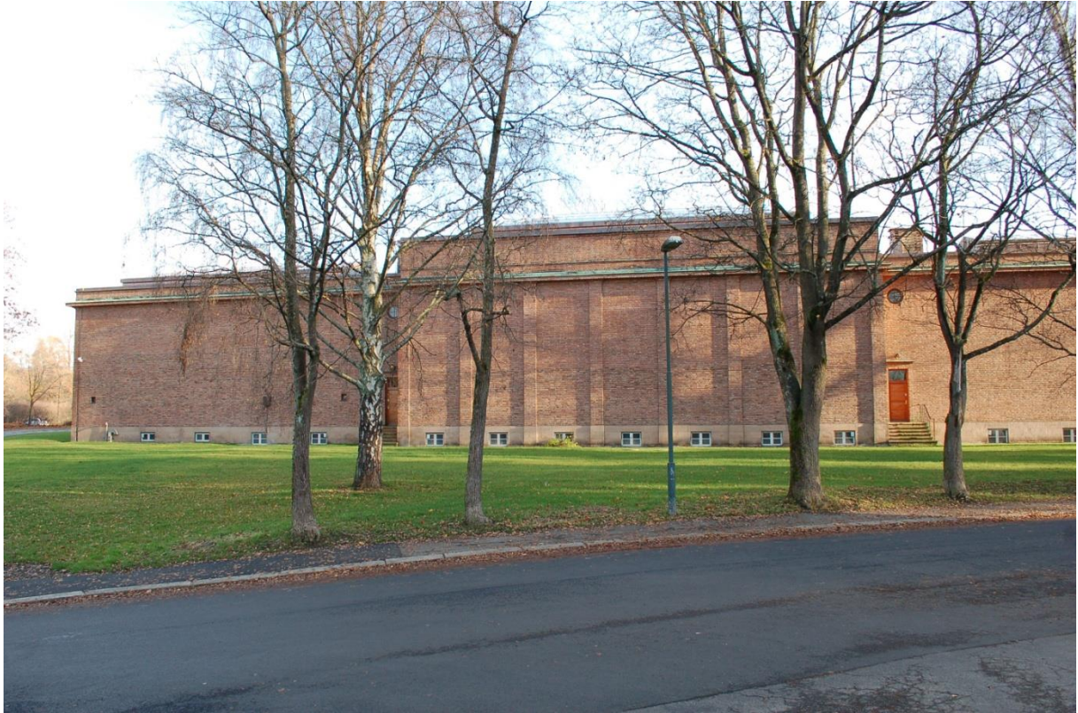
Fasade mot vest – Solheimgaten er også strengt symmetrisk utformet. Midtpartiet rommer Fontene-salen – og springer frem i fht. sidefløyene.
