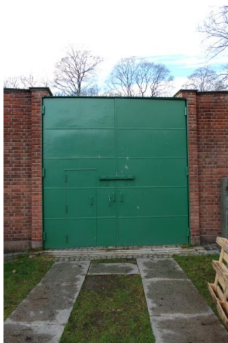
Adkomstport med innfelt gangdør.
