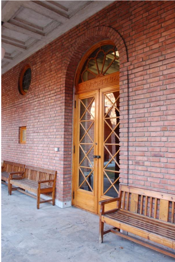
Monumentalt utformete dører til vestibyle.
