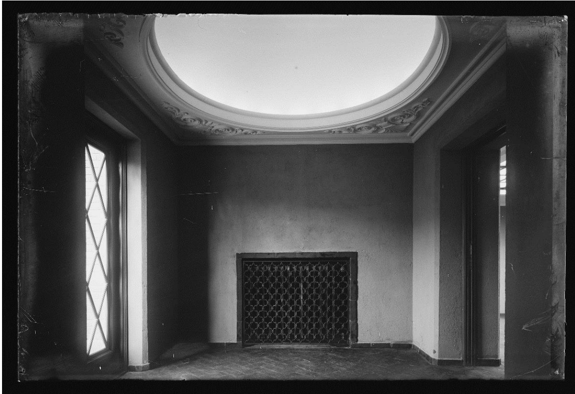
Gang i 2. etasje med adkomst til utvendig terrasse over sidefløyens loggia har kuppelformet himling med nyklassisistisk dekor av den flate delen av himlingen, samt vakkert utformet radiatorgitter og teglgulv.
