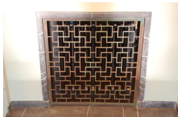
Eksempler på fint utformede ”ventilasjonsrister”, hhv fra Vigelands ateliersal og i hovedtrapp til 2. etasje.
