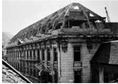
1 Site universitaire de la rue Mégevand à Besançon, travaux de transformations du toit pour l'installation des magasins de livres. Archives départementales du Doubs, fonds René Tournier 120J37. Emmanuel Laurent.
