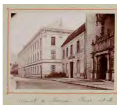
2 Le nouveau bâtiment de l'université au début du XX e siècle. Archives départementales du Doubs, 68J1. L. Besançon.
