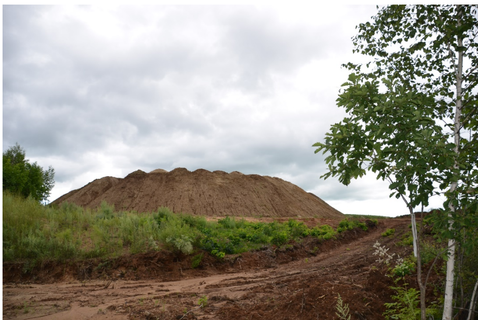
Рисунок 90 – Подготовка строительной площадки
