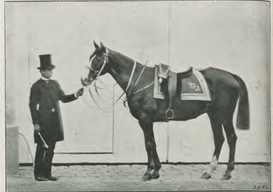
AJAX Cheval que montait Napoléon III à Solférino. D'après une photographie communiquée par M. Maurice Levert.
