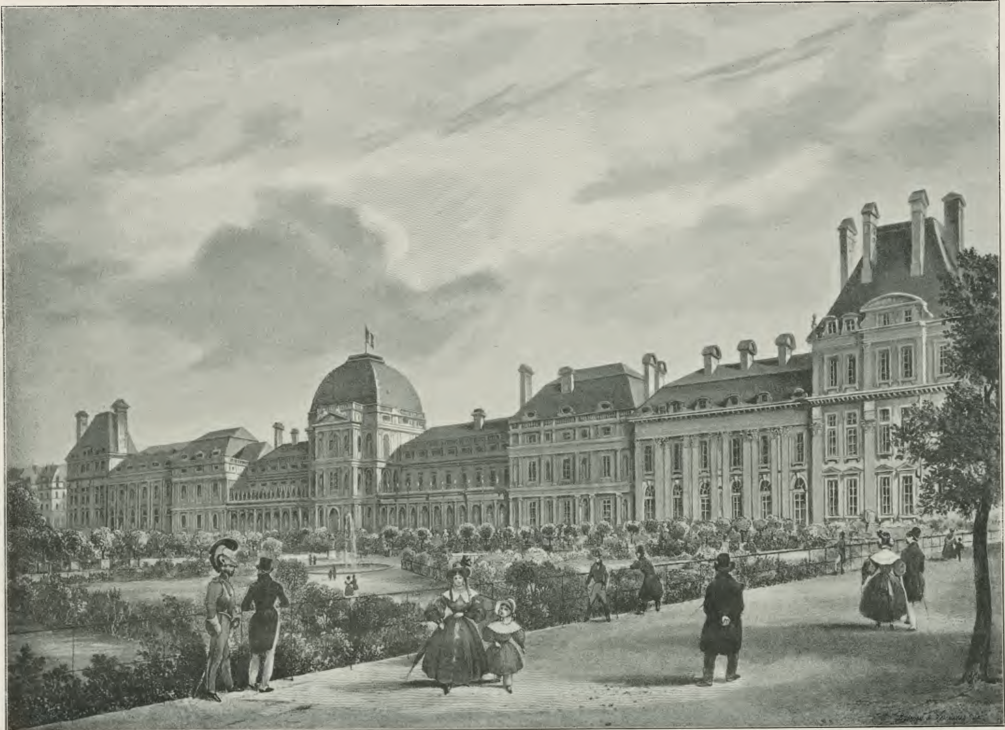
LES TUILERIES DU CÔTÉ DU JARDIN (SOUS LOUIS-PHILIPPE)
