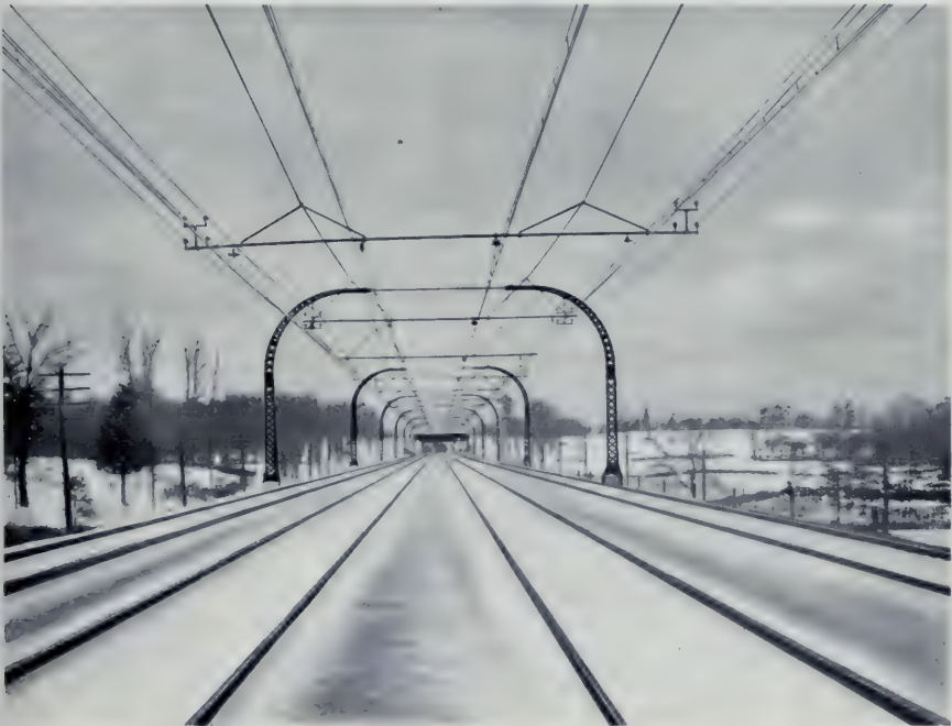
Recent Catenary Construction on N. Y., N. H. & H. R. R., near Glenbrook, Conn.
