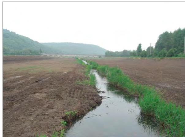
Abbildung 46: Beräumte Flutmulde unmittelbar nach der Baumaßnahme (Quelle: TLUBN)
