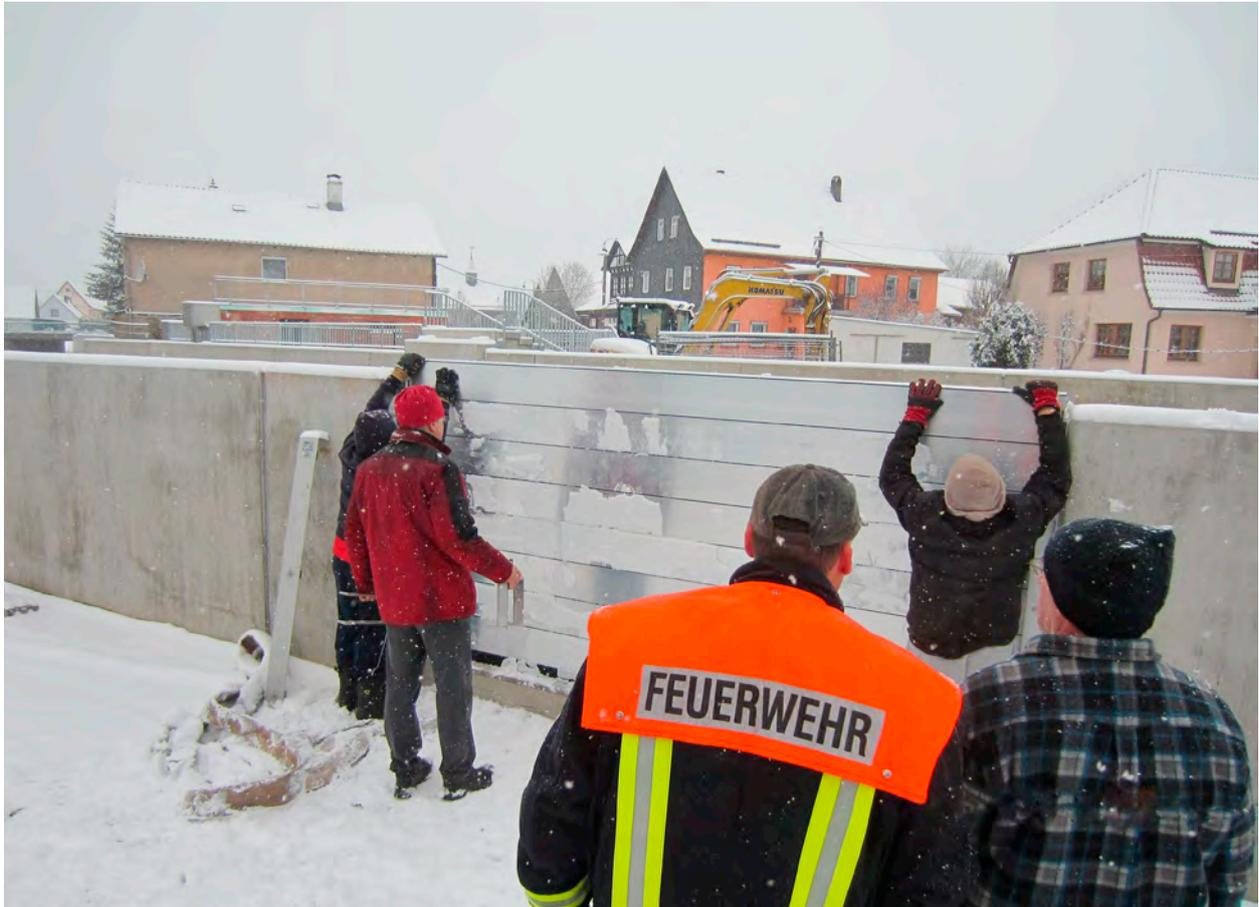
Abbildung 55: Dammbalkenverschlüsse Hochwasserschutz in Harras (Quelle: TLUBN)
