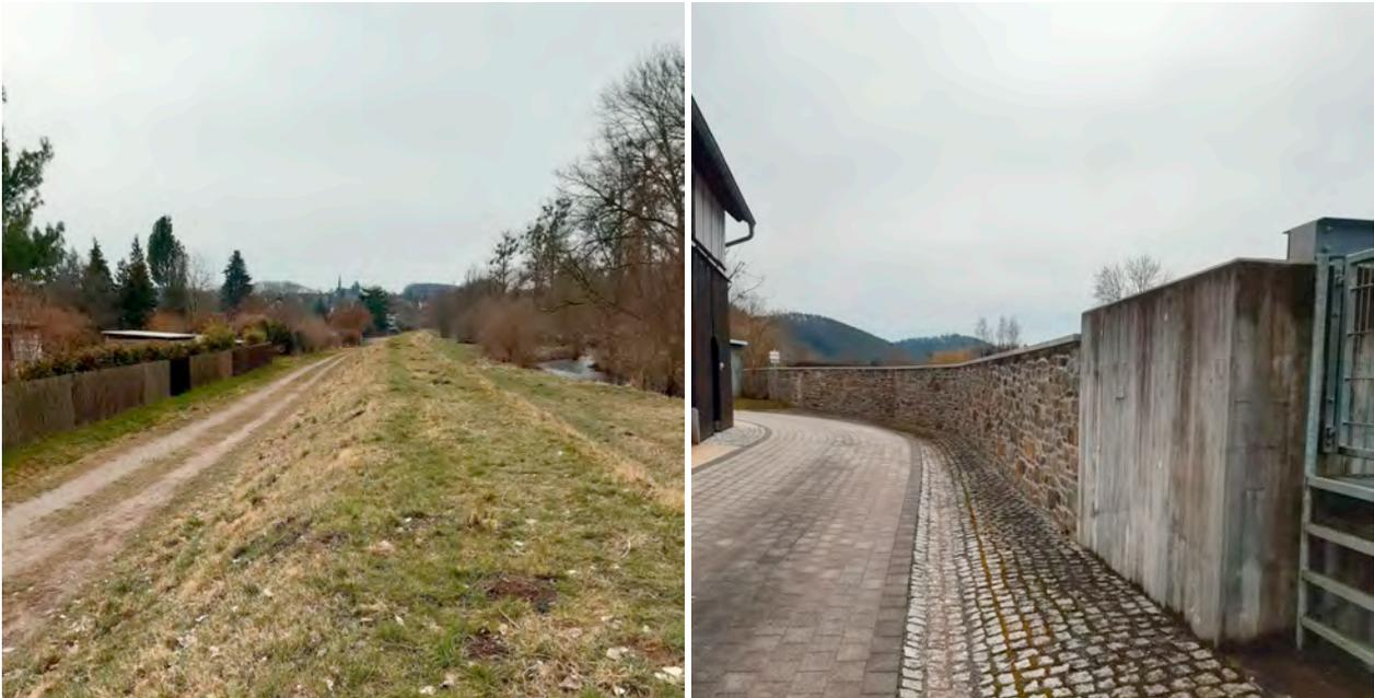
Abbildung 50: Deichbauwerk mit Deichverteidigungsweg in Wünschendorf (links); neu errichtete Hochwasserschutzmauer „Am Mühlgraben“ in Wünschendorf (rechts) (Quelle: TLUBN)
