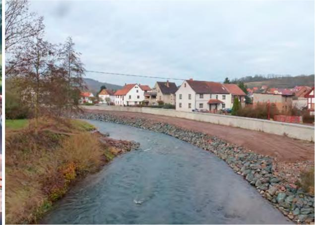
Abbildung 52: Fertigstellung der Hochwasserschutzmauer Stedtfeld (Quelle: TLUBN)
