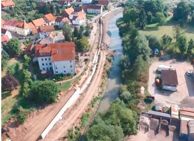
Abbildung 51: Errichtung der Hochwasserschutzmauer Stedtfeld (Quelle: TLUBN)
