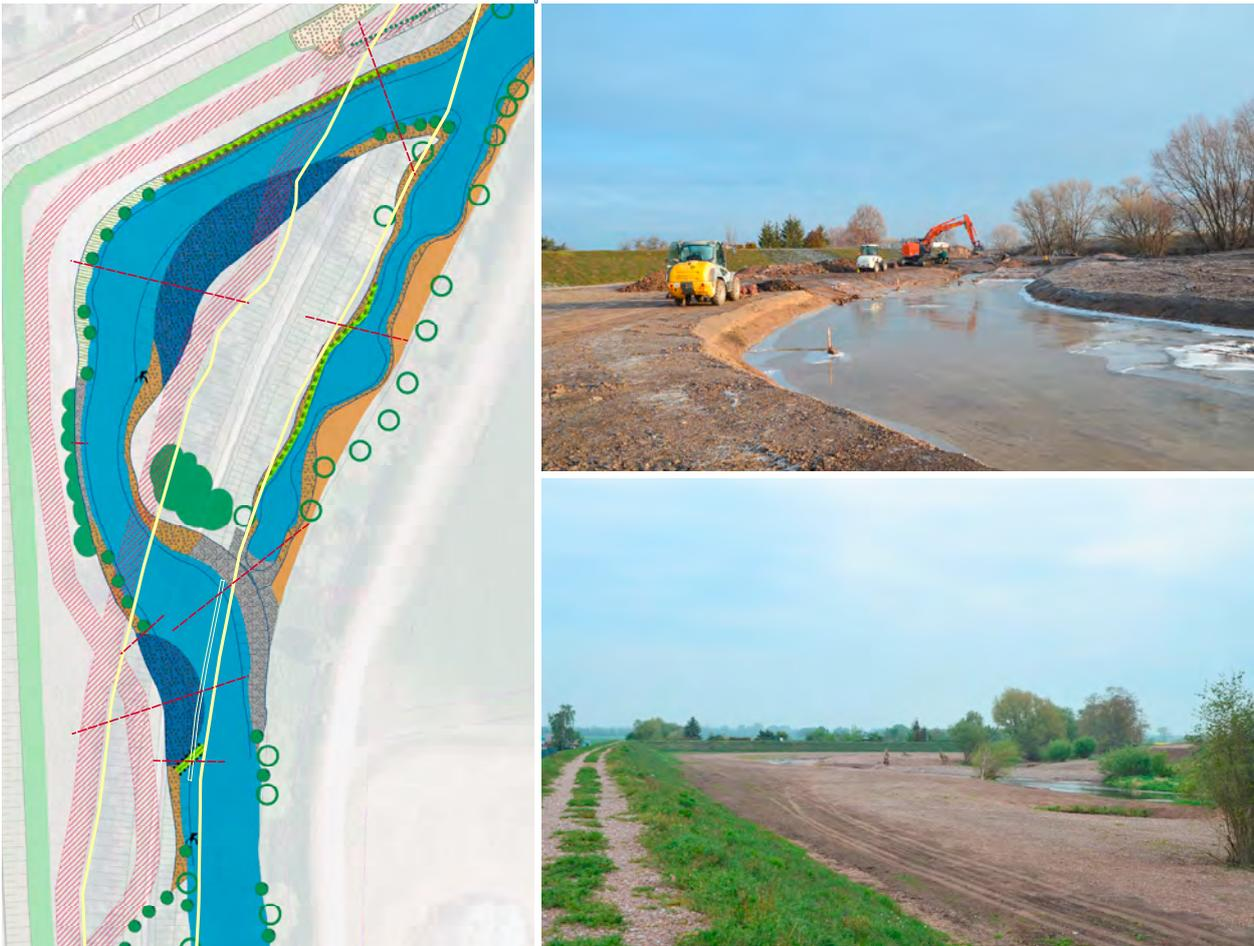
Abbildung 27: Umgestalteter Bereich der nördlichen Gera bei Walsleben (links) (gelbe Linie: Rückbau des Altdeiches); Entstandener Raum für den Hochwasserrückhalt und für eine naturnahe Gewässerentwicklung und Auenrenaturierung (rechts) (Quelle: Andraczek, I.)
