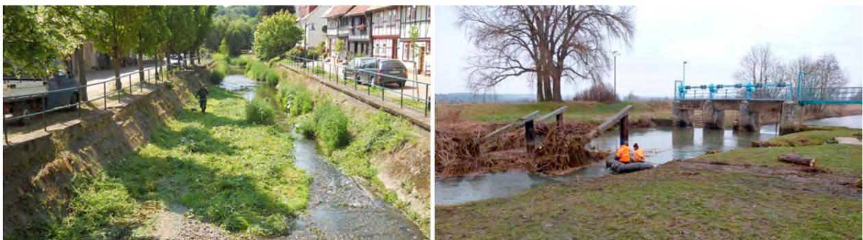
**Abbildung 29: Mähen (links) und Beseitigung der Abflusshindernisse (rechts) im Rahmen der Gewässerunterhaltung (Quelle: Eichholz, N.)**
