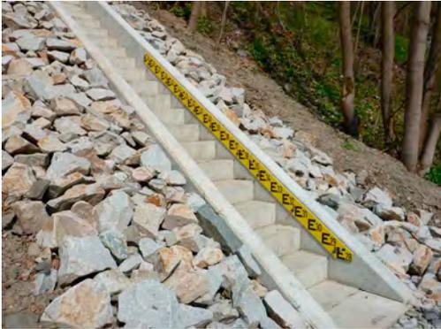
Darüber hinaus gibt es in Einzelfällen grundsätzliche Erweiterungen des Pegelmessnetzes durch Pegelneubauten. Zuletzt wurde in Ziegenrück an der *Saale* ein Pegel neu eingerichtet. Bei Hochwasser kann mithilfe dieses Pegels eine bessere Einschätzung der Situation in der Stadt Ziegenrück gewährleistet und die Abgabe aus der TS Bleiloch bzw. der TS Burgkhammer besser überwacht werden.
