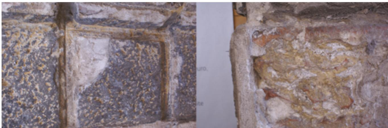
7. Prospetto delle Peschiere di Levante: bugna grigia colorata in pasta su arriccio in calce e sabbia (a sinistra); bugna mossata gialla con finitura colorata in pasta su arriccio in calce e sabbia (a destra).
