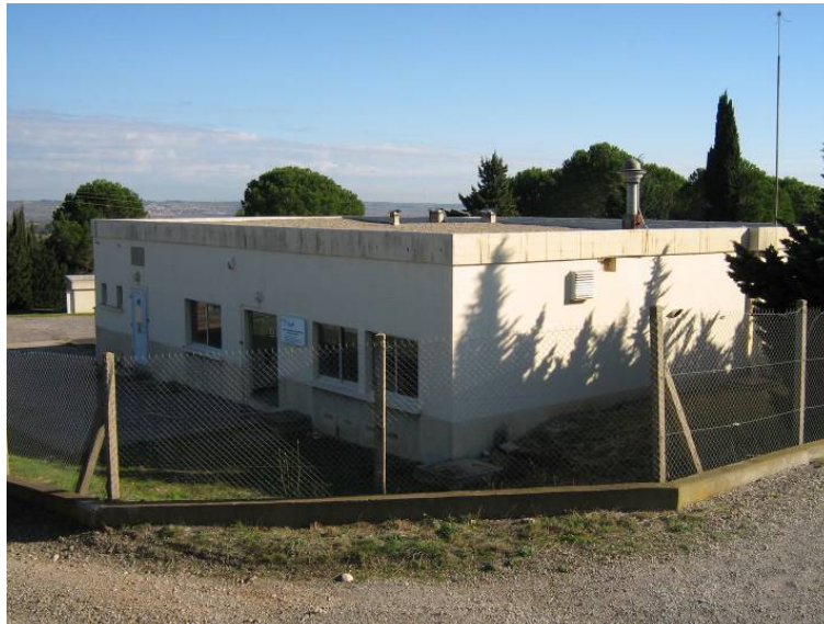
Figure 24 : Station de traitement AEP de Cazouls les Béziers
