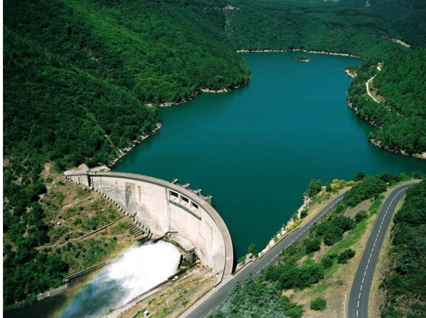
Figure 1 : Le barrage des Monts d'Orb
