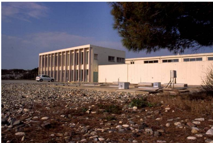
Figure 20 : Station de traitement AEP de Puech de Labade
