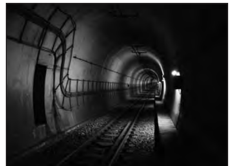
Tunnelführung (19.30 h, Bielefeld, Betriebshof Sieker)
