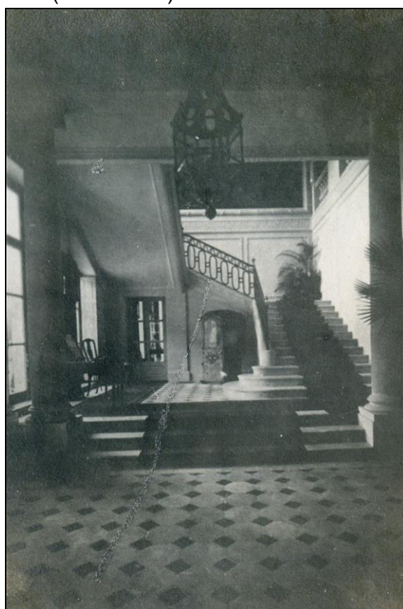
Le vestibule d'entrée du château vers 1910.
