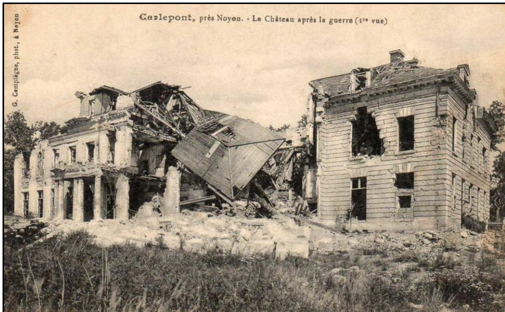
Fortement atteint par les bombardements de 1918, le château de Carlepont est en ruines (1919).
