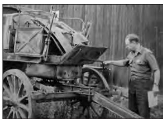
Eric Engström 4 augusti 1988 vid renoveringsobjekt elverk.
