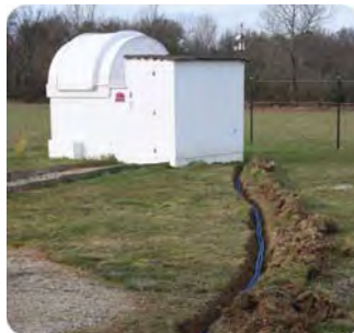
Mise en situation dans des gaines
