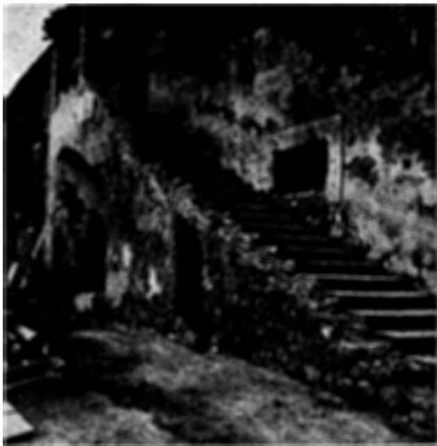
Fig. 7 La scala dopo i primi « saggi ». È evidente la sovrapposizione della scala recente a quella originaria.
