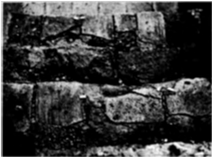
Fig. 8 - I gradini originari come furono trovati sotto la scala recente: corrosi e sconnessi, testimoni della povertà cui era abbandonata la « cascina antica ».
