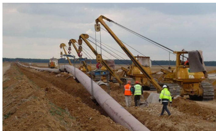
Figure 4 : Mise en fouille par les sidebooms
