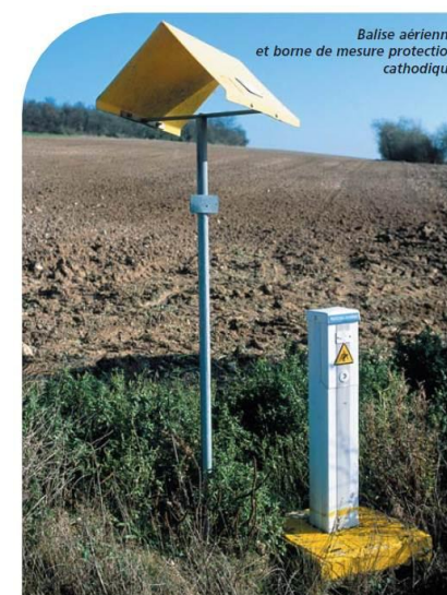
Photographie 1 : Balise aérienne et borne de mesure protection cathodique
