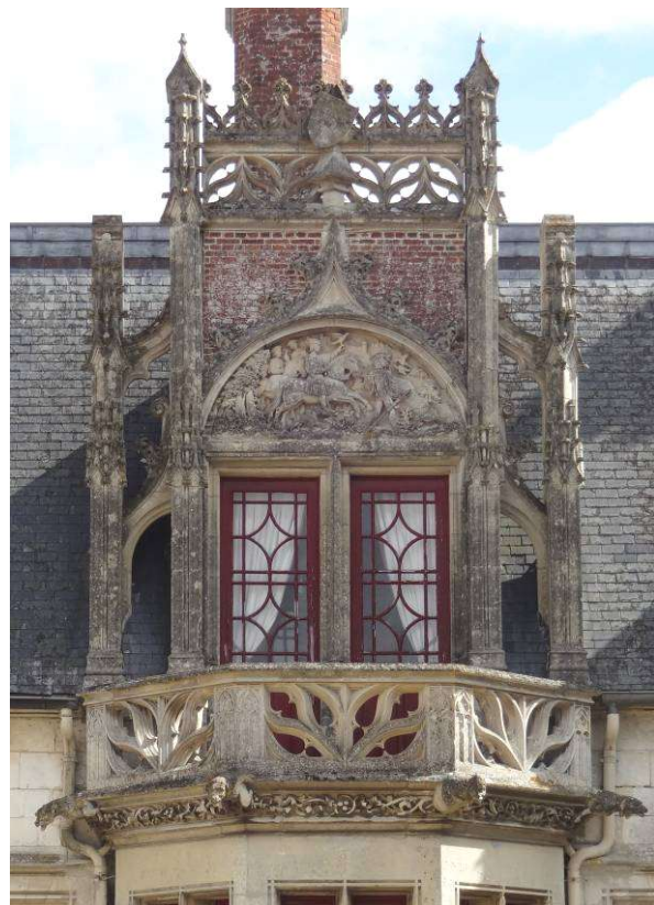
Aile centrale côté cour : bow-window et balcon gothique. Lucarne avec pinacles ornés de crochets, surmontée d'un bas-relief représentant une scène de chasse au faucon (détail ci-contre)
