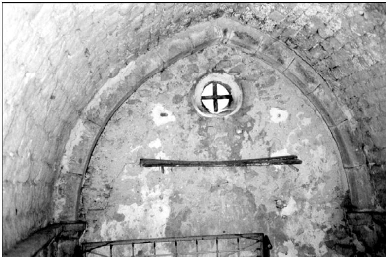
Doc. 40 : Sahune, église Saint-Jean, détail de l'intérieur, voûte à berceau semi-brisée
