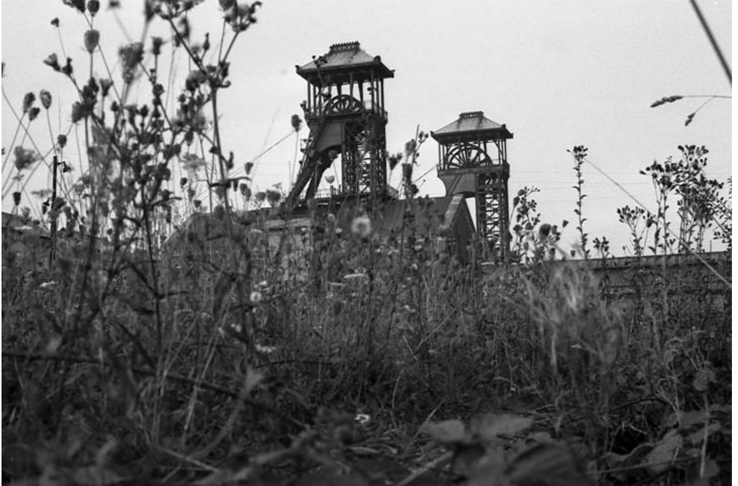
Découverte du milieu industriel et du monde ouvrier – Charbonnages de France – Fosse Lemay
