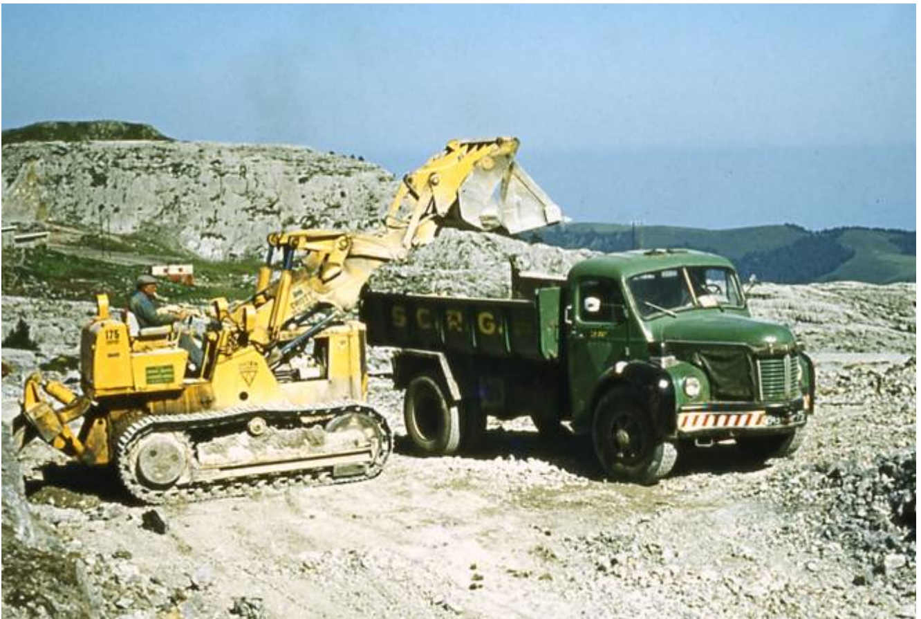
Construction de la future station le la Pierre Saint-Martin
