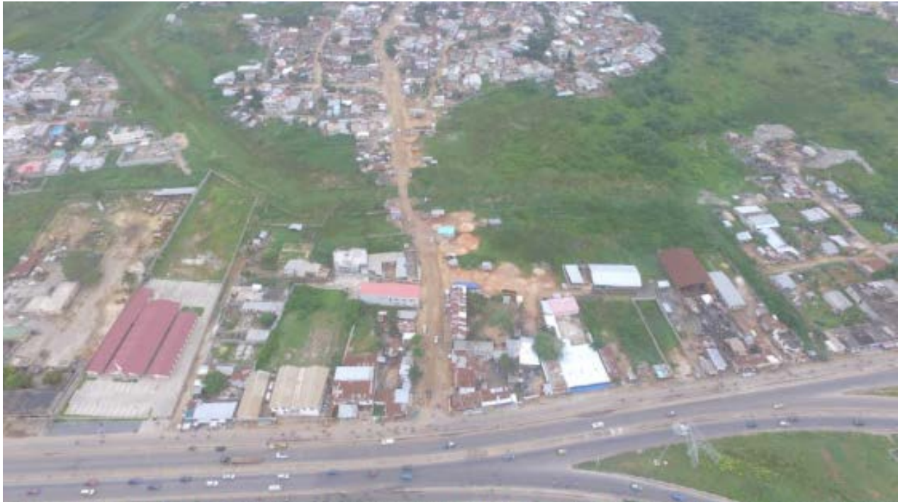
Figure 9 : image drone du bassin XX (partie nord jouxtant l'échangeur de Godomey)
