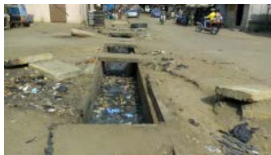
Caniveau non curé, dalles non posées
