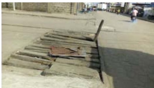
Rue 4.107 : dalles remplacées par du bois
