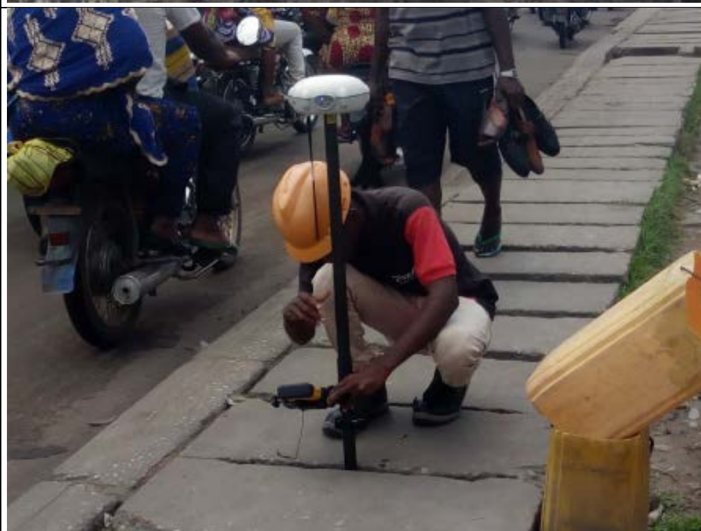
Photo n°6 : Equipe topographique avec une station GPS différentiel en activité / Levé de détails – fil d'eau de l'ouvrage d'assainissement existant
