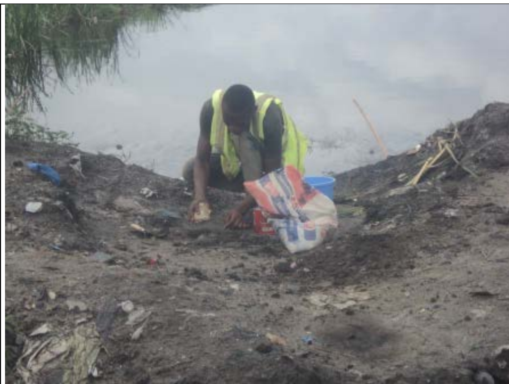
Photo n°5 : Mise en place d'une borne topographique en béton
