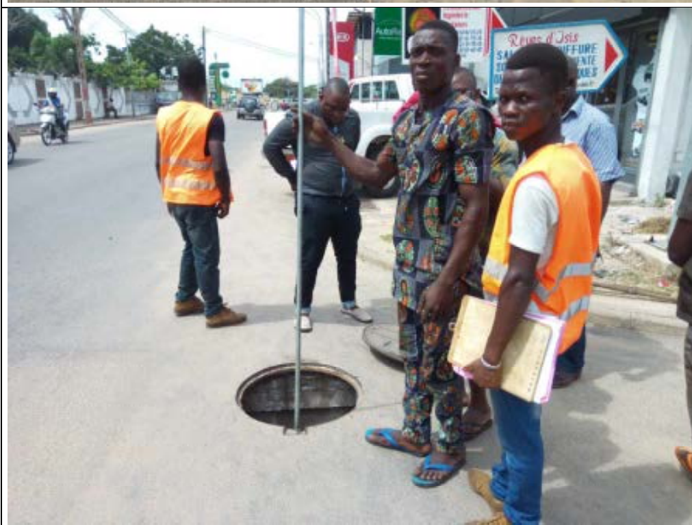
Photo n°8 : Opération de mesure de fil d'eau à l'aide d'un fer métallique
