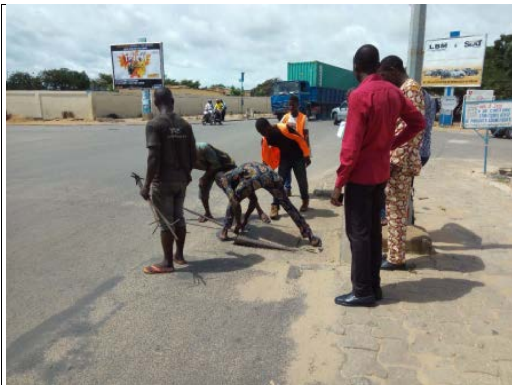
Photo n°7 : Opération d'ouverture des regards pour la mesure du fil d'eau sur ouvrage d'assainissement existant.
