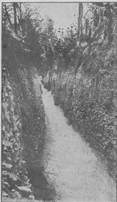
1915 - Août - Le boyau des Marquises
