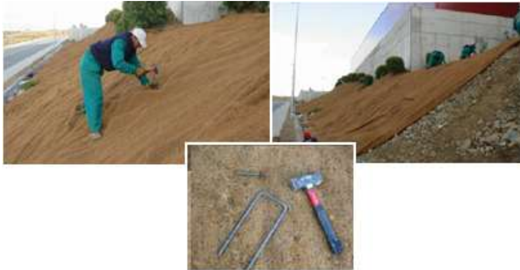
Figura VI.15 Malla orgánica, materiales necesarios para su colocación.
