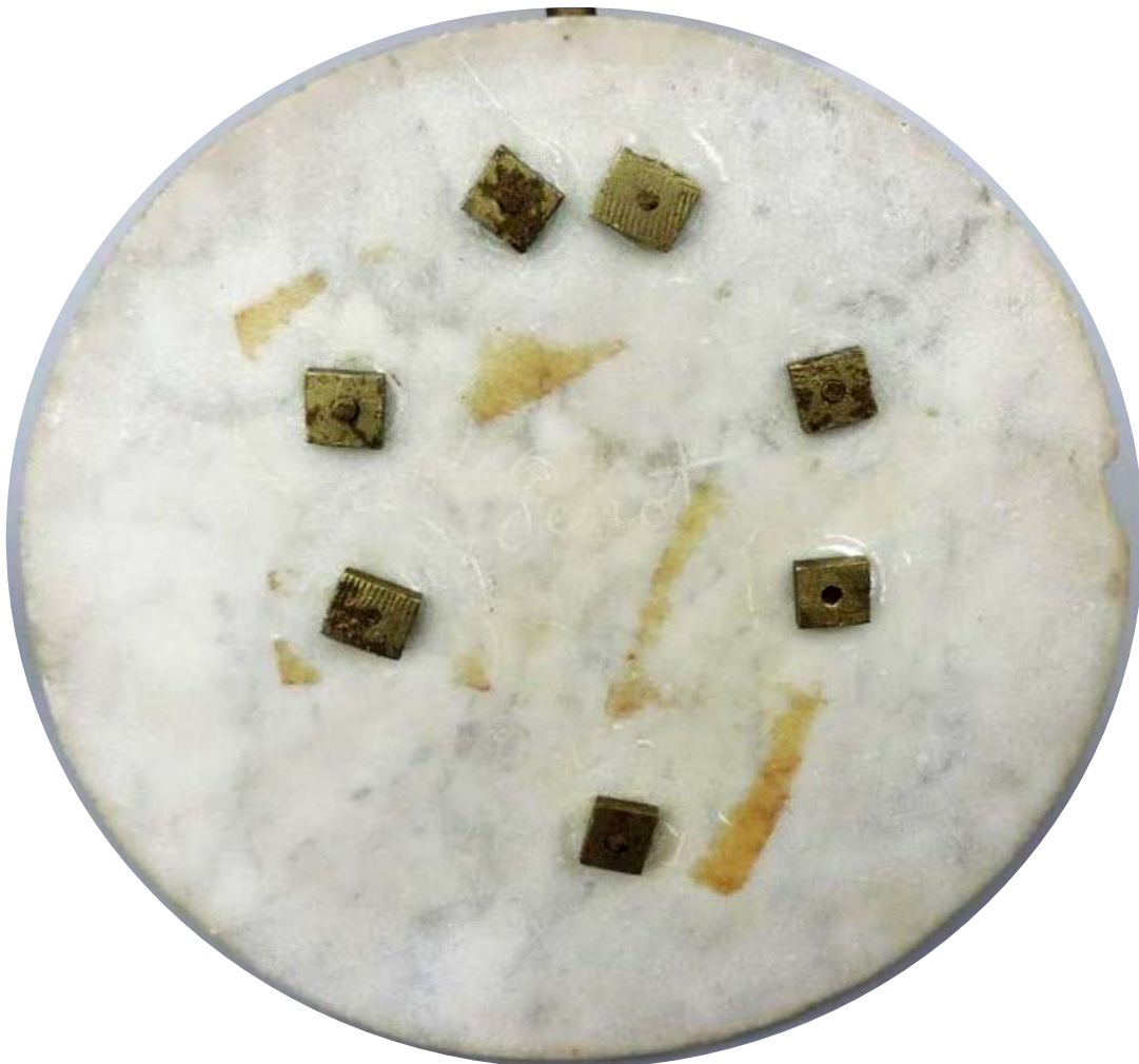
Tornillos de sujeción: gualderas (2), soportes (2+2), gnomon (1).
