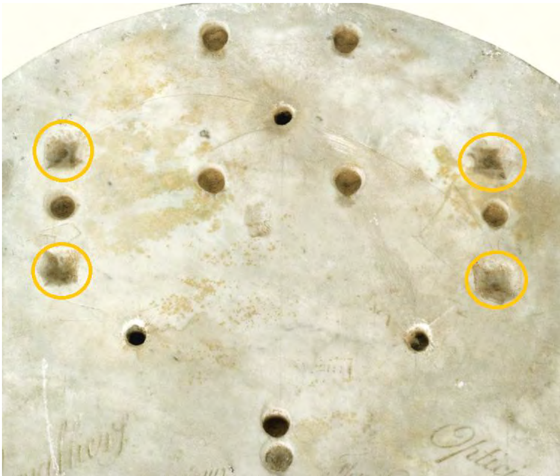
Orificios de los pivotes de los soportes campaniformes de la lente.
