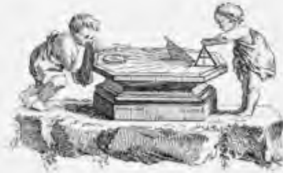
Verification of the horizontal plane and construction of a horizontal sundial Bodon de Cellis, La géométrie pratique, Paris, 1760 Library of the Musée d'histoire des sciences
