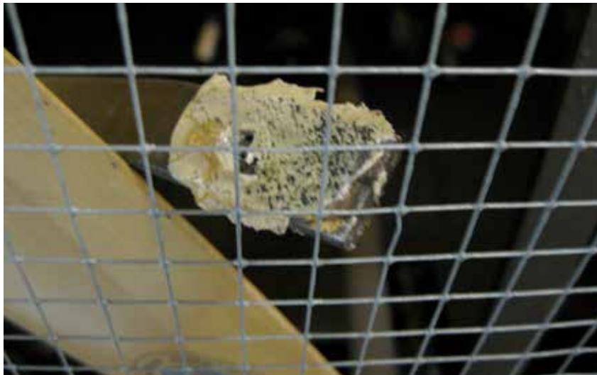
traces de l'ancien adhésif sur la barre métallique de la 1.0.
