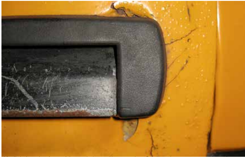
détail de la poignée extérieure de la portière gauche : fissures, lacunes, corrosion, cloques.
