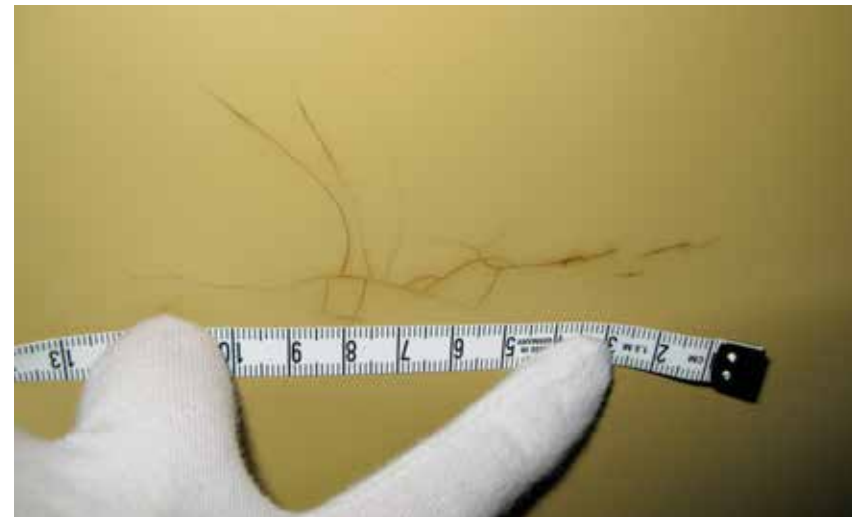
détail d'un réseau de fissures sur l'aile arrière gauche de la 1.0 + corrosion
