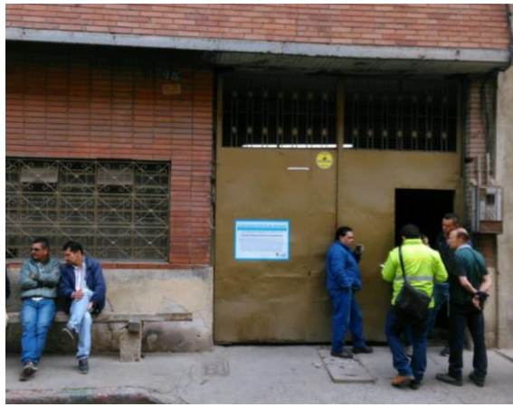
PREDIO No.16. CURTIEMBRES LOZAMORAS. CALLE 59 SUR No. 18 22
