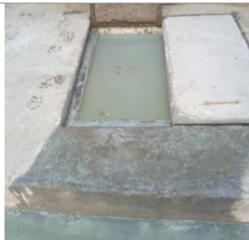
Fotografía 3. Caja de inspección externa del predio ubicado en la KR 18C No. 59–13 SUR, en el cual se evidencia la generación de ARnD provenientes de las actividades desarrolladas en el mismo, incumpliendo la medida de suspensión de actividades previamente impuesta, así como vertiendo ARnD en vía pública .
