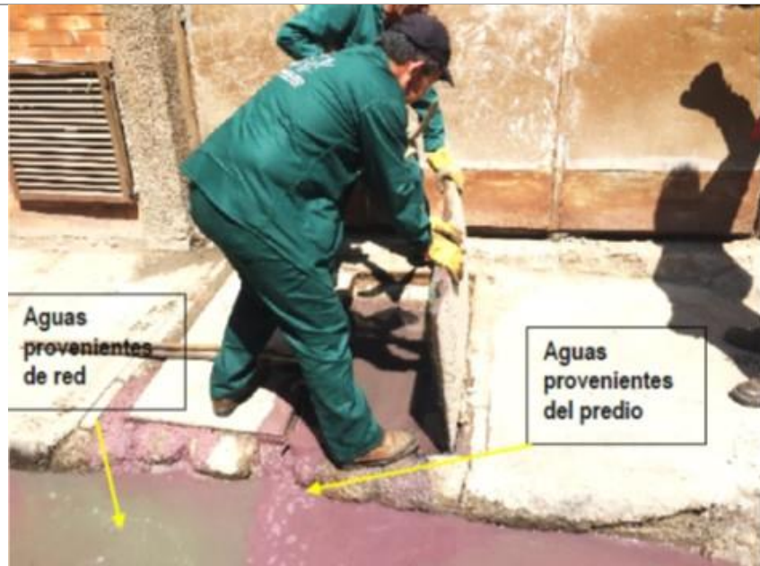
Fotografía 1. Caja de inspección externa del predio ubicado en la KR 18C No. 59 – 23 SUR, en el cual se evidencia la generación de ARnD provenientes de las actividades desarrolladas en el mismo
