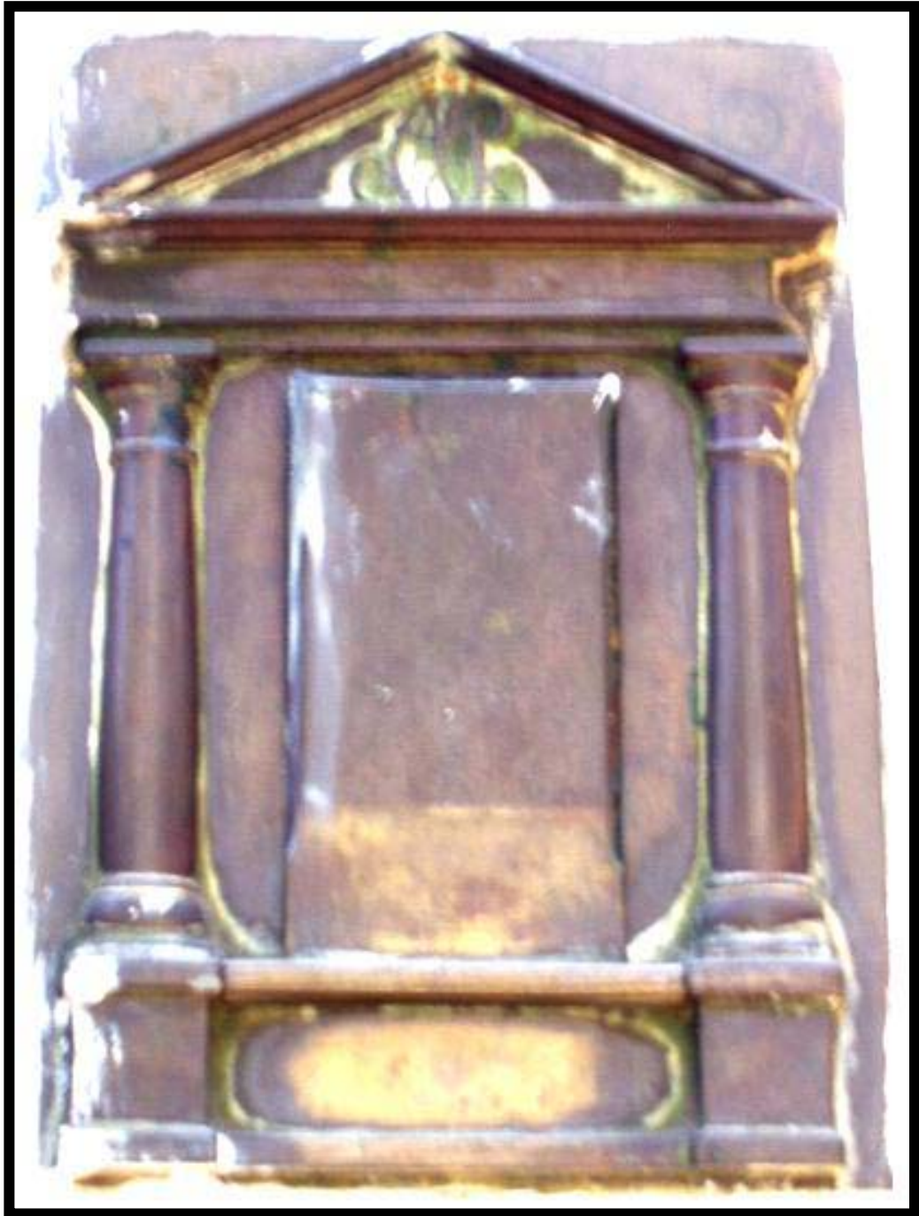
Figura 7: Fechadura do solar da família Clemente Pinto. Esta fechadura encontra-se na porta da fachada, mas o solar possui outras como esta no seu interior. A porta de bronze se abre para o local da chave e em cima, no frontão, o monograma com as iniciais ACP de Antonio Clemente Pinto. Fonte: Acervo do autor.
