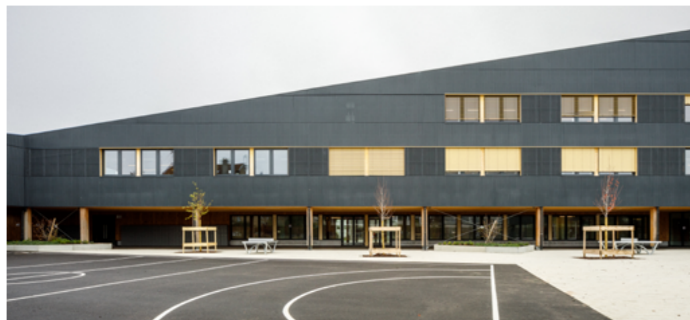
Façade sud-ouest sur cour
