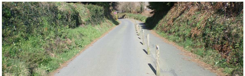
Figure 12 : Voie à sens unique et voie piétonne.
