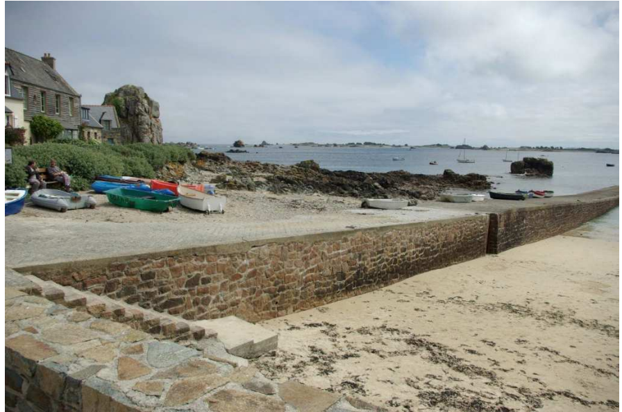
Figure 8 : grande cale de mise à l'eau de Pors-Hir. Noter la différence de niveau entre la partie gauche et la partie droite, due à l'accumulation des galets contre le flanc nord de la cale provoquant le blocage des transits causé par la cale.
