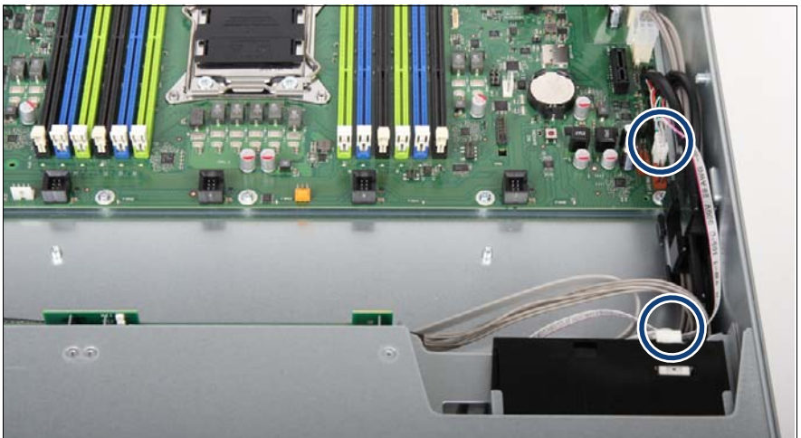
図 173: LSD ケーブルの取り外し
