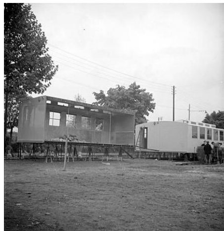
Construction de classes « wagon » ( Photos Ministère de la Culture )
