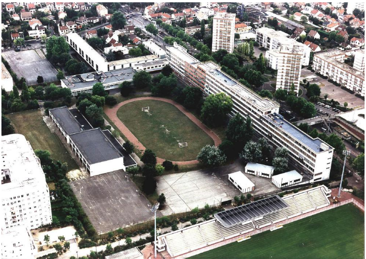
Conséquence du classement du Lycée Joliot-Curie en ZEP Manque de place = Apparition des premiers bâtiments préfabriqués sur un terrain de Hand-Ball
