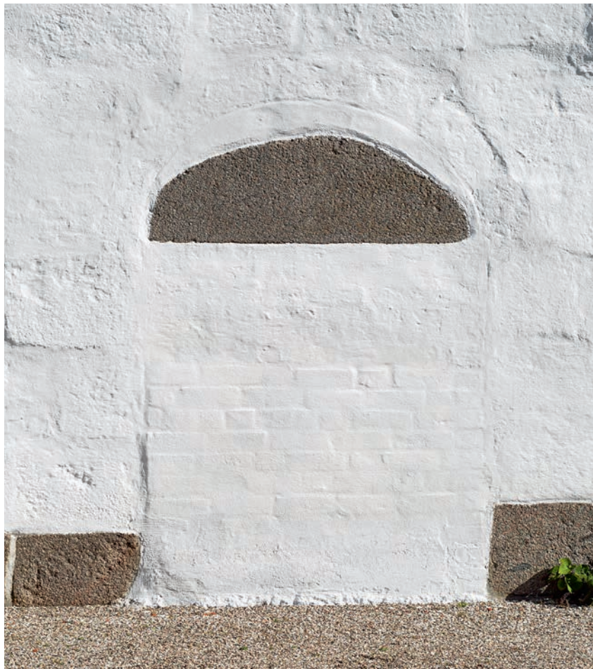
Fig. 63. Skibets blændede syddør (s. 3928). Foto Arnold Mikkelsen 2016. – Bricked-up south door of nave.
