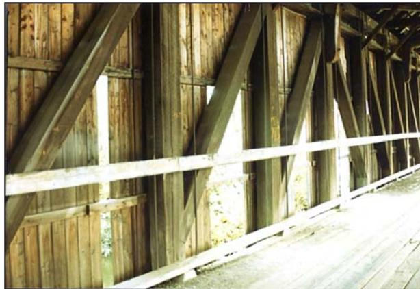
Fig. 5 : Détail d'une ferme à poinçons multiples.
