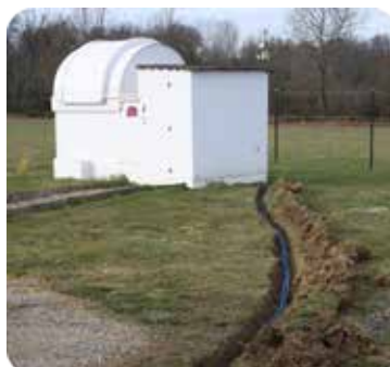
Mise en situation dans des gaines
