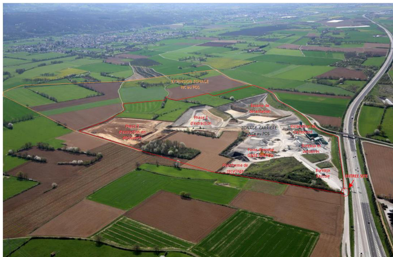
Vue aérienne de la carrière de Sillans et de son extension future – source CEMEX GRM
