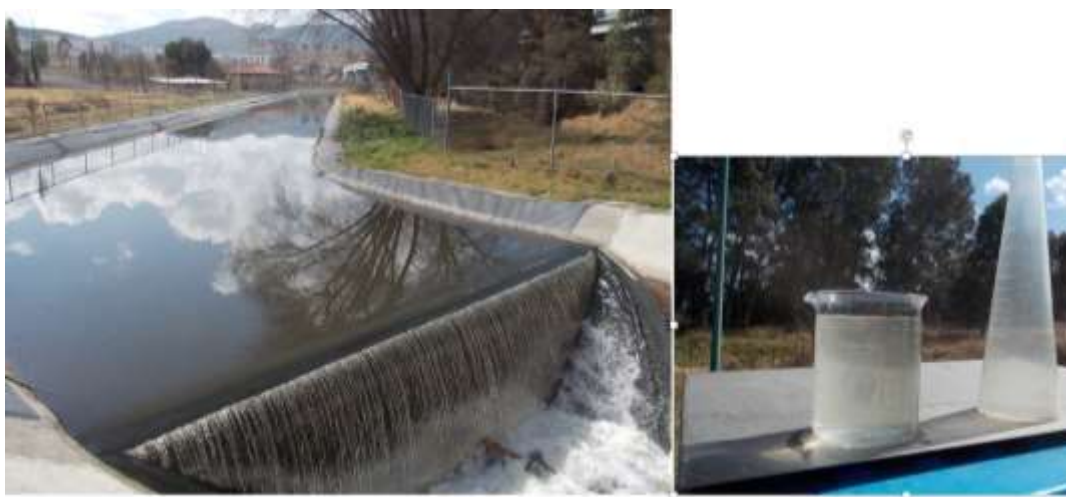
Ilustración 53. Descarga de agua tratada de la PTAR Atapaneo al Río Grande de Morelia. Nota. Fotografía tomada en campo.
