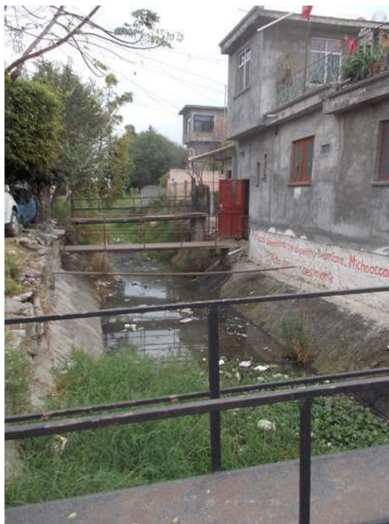
Ilustración 35. Invasión de los canales de riego en Uruétaro. Nota. Fotografía de las visitas de campo.
