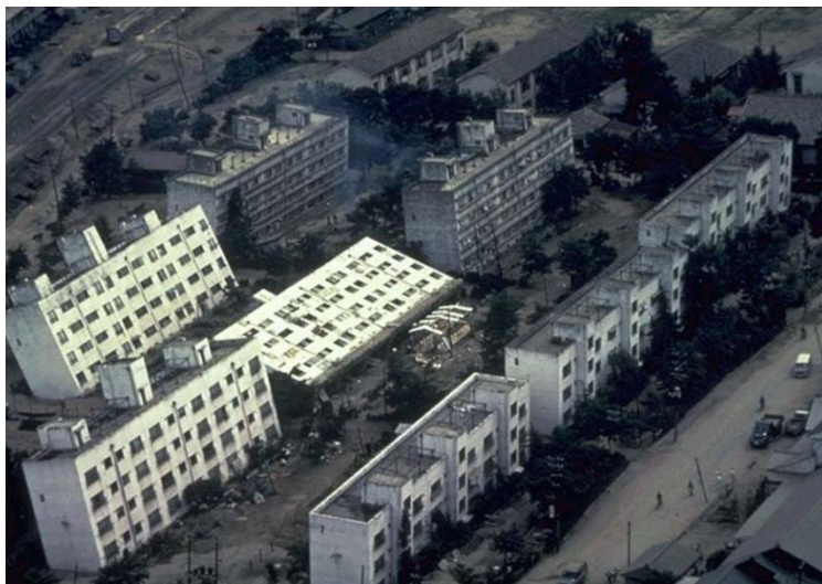
Figura 28. Licuefacción sismo de Niigata, Japón, 16 de junio de 1964 (M=7.5)
