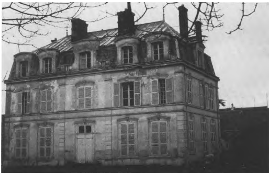
Massy La demeure avant sa démolition.
