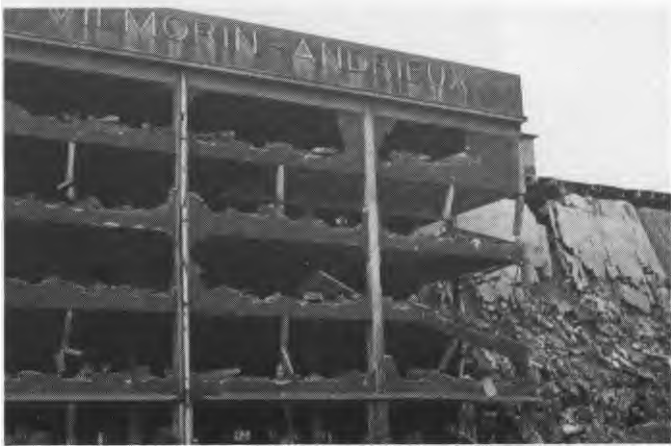
et démolit en Août 1972.
