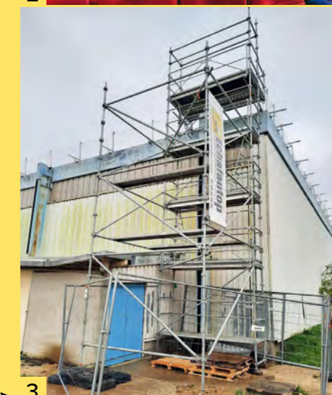
1. Photographie de la salle de spectacle avant travaux. 2. Photographie après travaux. 3. Photographie des travaux de la toiture du Gymnase. >
